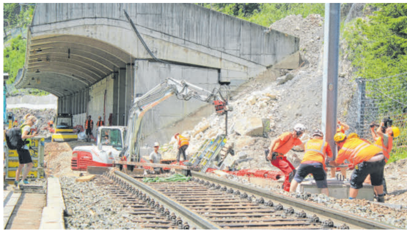
Einem Monat lang wurde entlang der Arlbergbahnstrecke, wie hier im Bereich der Löcherwaldgalerie in Wald a. A., intensiv gearbeitet.
