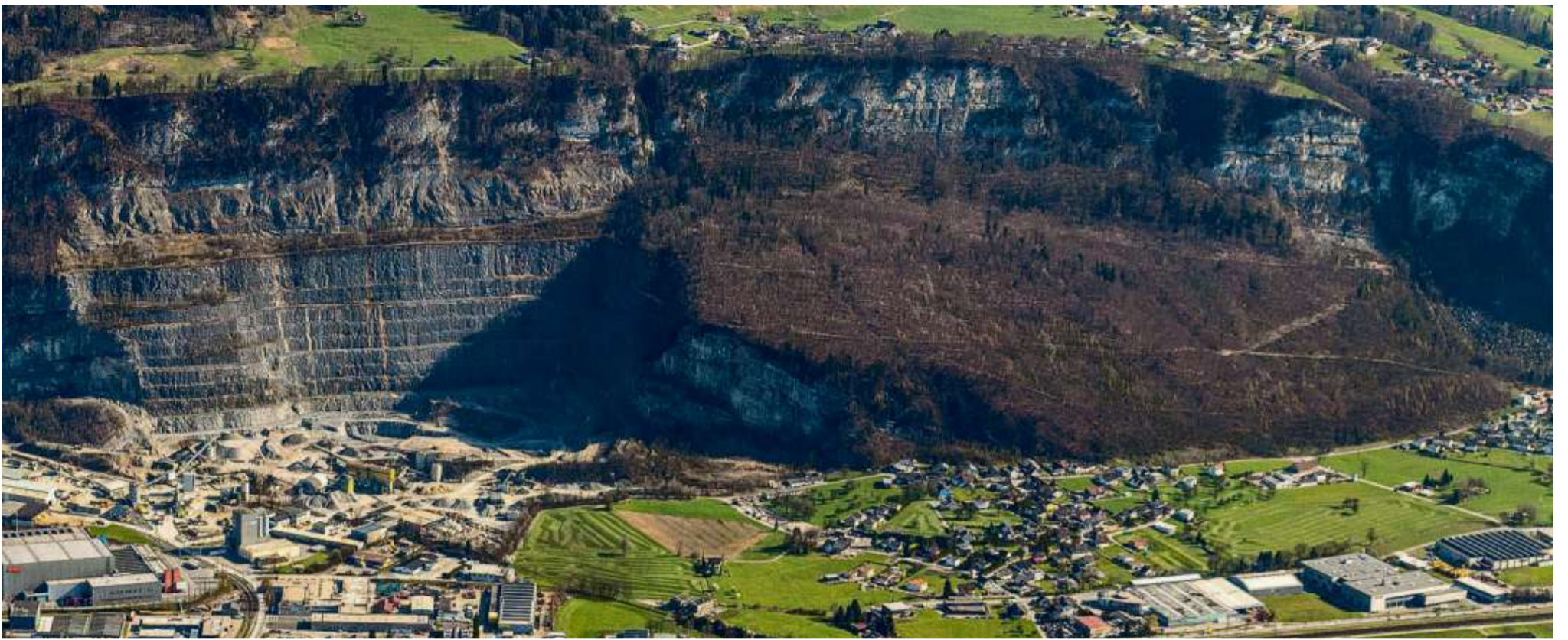
„Nahversorger“ für Baumaterialien: Im Steinbruch Unterklie gewinnt Rhomberg unter anderem Rohstoffe für neuen Wohnraum im Ländle.
